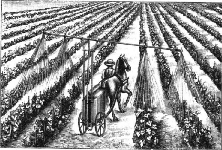
Fig. 2. Pulverisator Nr. 2 mit horizont. Ausflußrohr für Pfahlanlagen.
