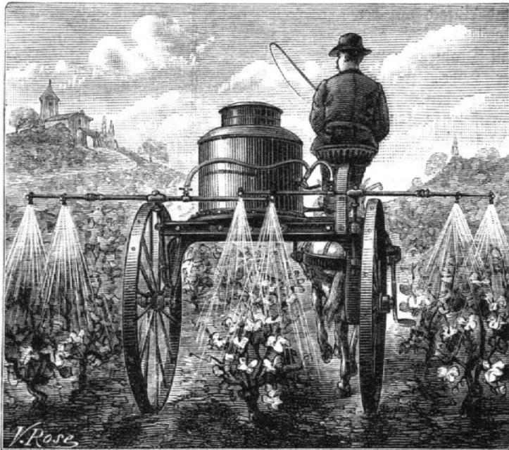
Fig. 1. Pulverisator Nr. 1 für niedere Weinberge.
